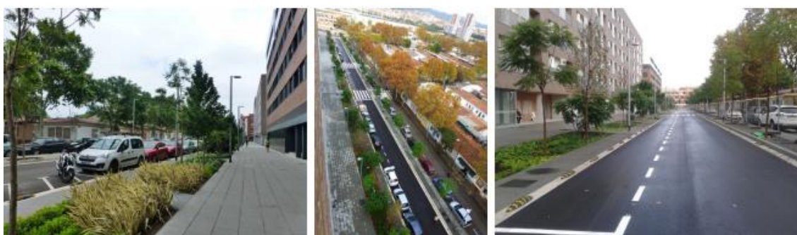
Figura 4: Barrio de Bon Pastor (Barcelona). Calles con franjas de biorretención en calzada. Fuente: R. Soto Fernández y R. Perales Momparler
