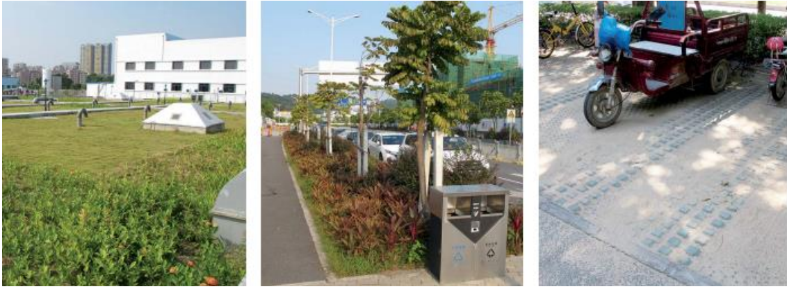
Figura 6: Algunos elementos de la ciudad esponja en el nuevo suburbio Guangming son (de izquierda a derecha): un techo verde sobre la planta de tratamiento de aguas, canchales con plantas en una escuela y calles y estacionamientos permeables. Foto: Matt Jenkins.
