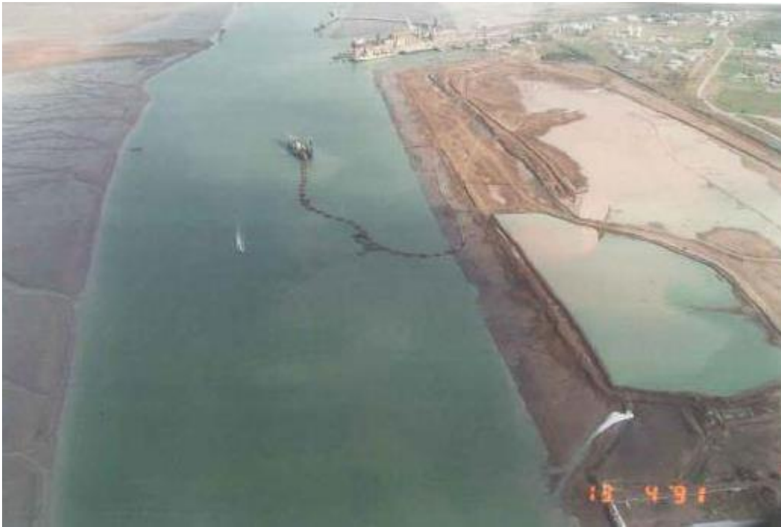
Obras de dragado en el Sector de Cangrejales en el año 1991
