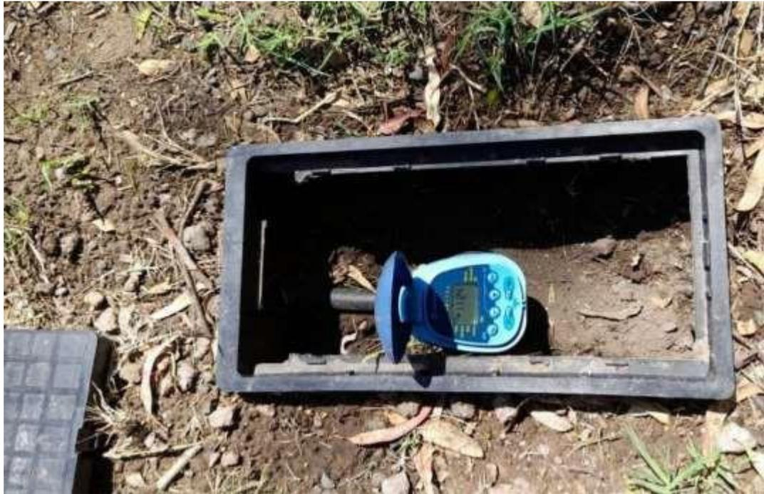
Figura 22: Instalación de programador de riego.
