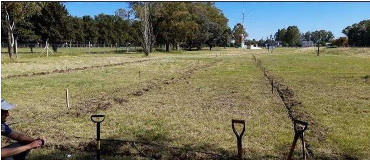
Figura 16: Zanjeo y entierro de líneas de riego.
