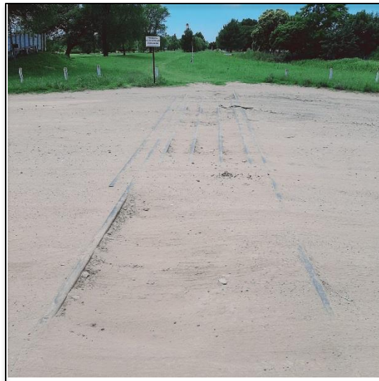
Figura 7 Tendido de vías
