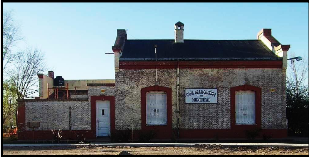
Estación del ferrocarril (fachada)
