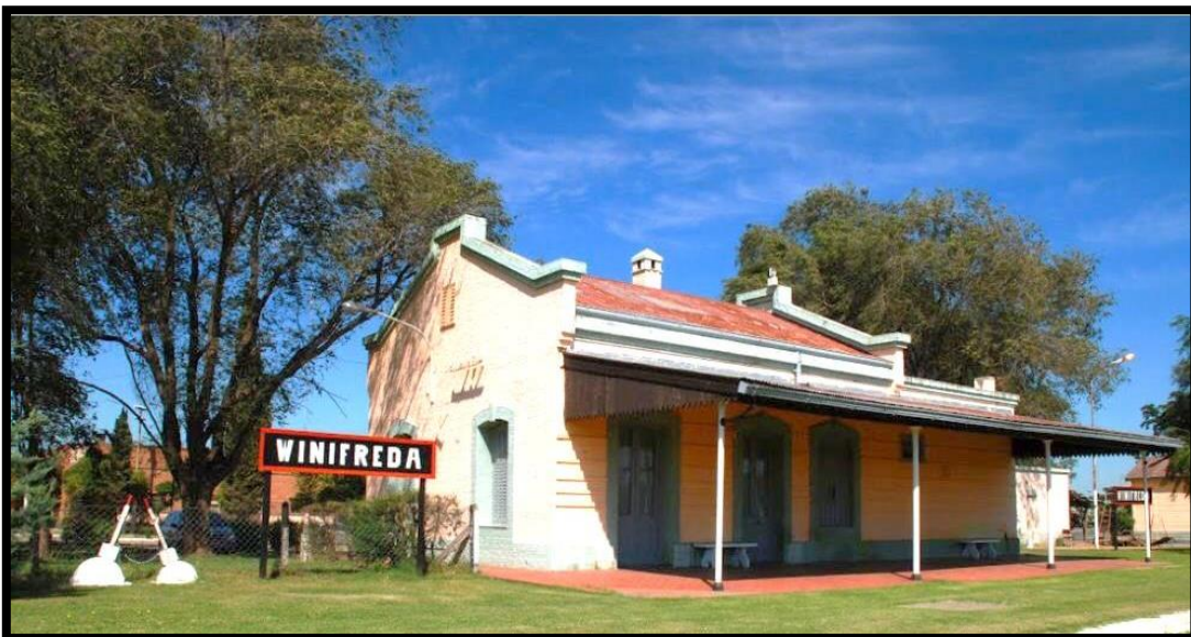
Estación del ferrocarril (sector del andén)
