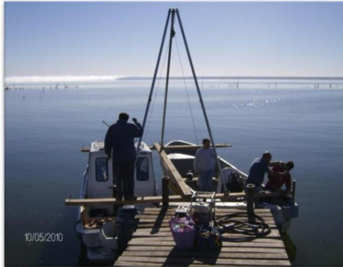
Fig 11: Plataforma y sistema contruidos a fin de poder obtener un testigo en el lago Chasicó.
