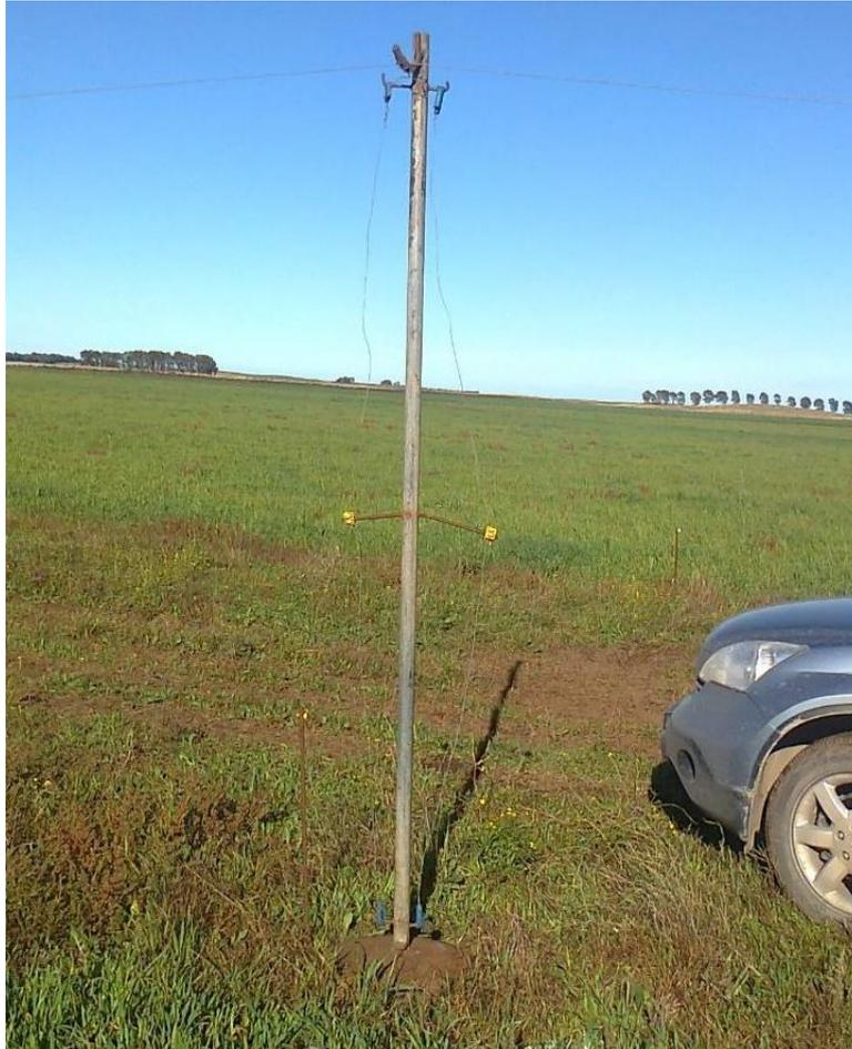
Foto 9. Caño de aluminio con accesorios para la conducción eléctrica.
