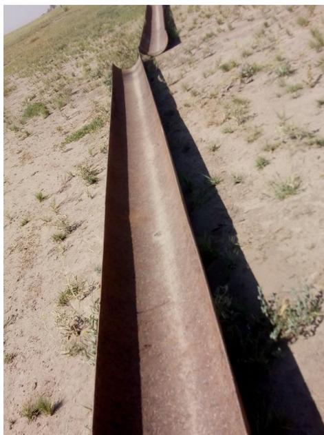
Foto 31. Vista del corte transversal del caño de gas en desuso para comedero de ganado bovino.
