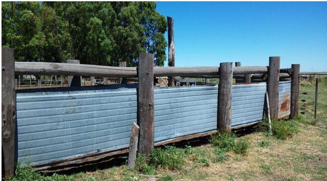
Foto 37. Lateral del corral elaborado con palos de palmera descartados del tendido eléctrico.
