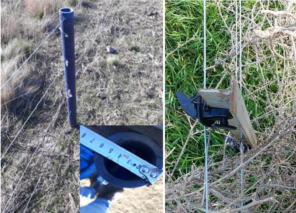
Foto 12 y 13. Caño de Pvc rígido (izquierda) y hierro “T” (derecha), utilizados como postes o en algunos casos como varillas para alambrados internos.
