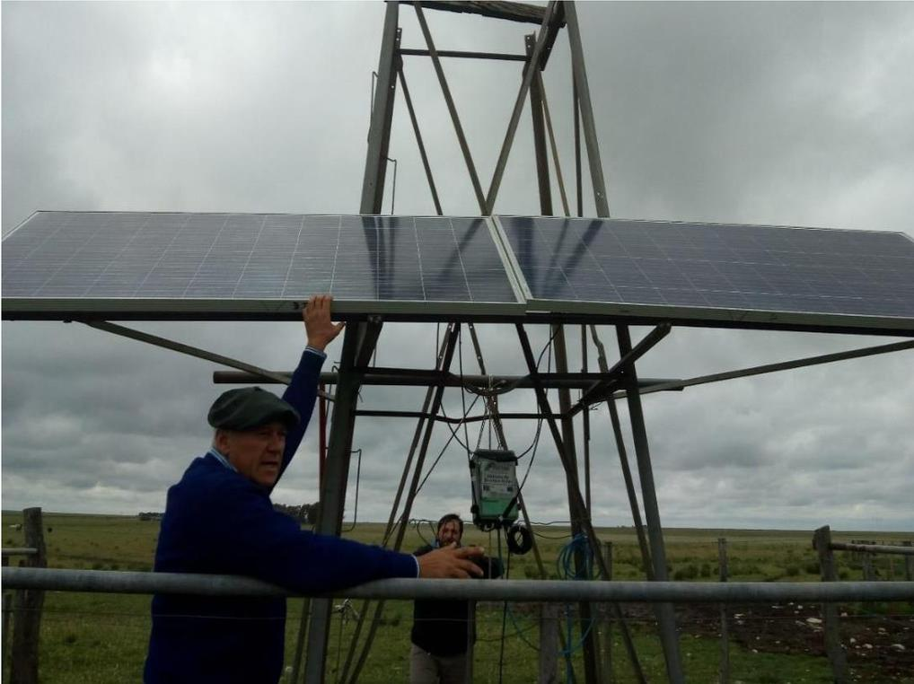
Foto 57. Paneles solares de alimentación para bomba sumergibles.
