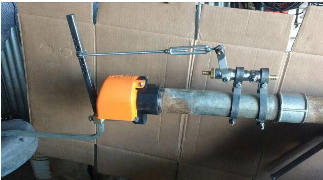
Foto 15. Sistema de accionamiento automático, desde el flotante.
