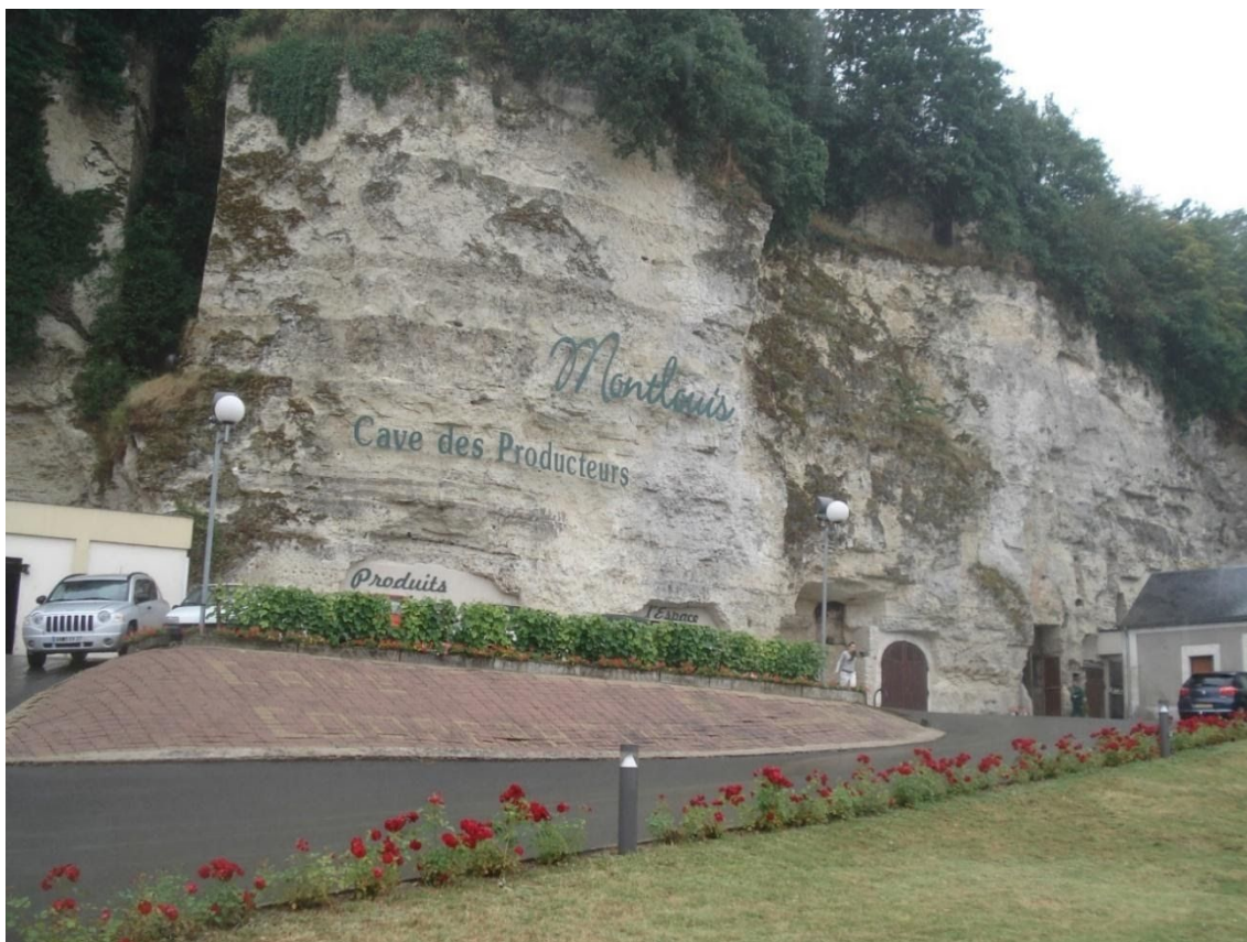
Fig. 6. La Cava de Productores de vino de Montlouis sur Loire. Fuente: Foto Florencia Hirsfeld
