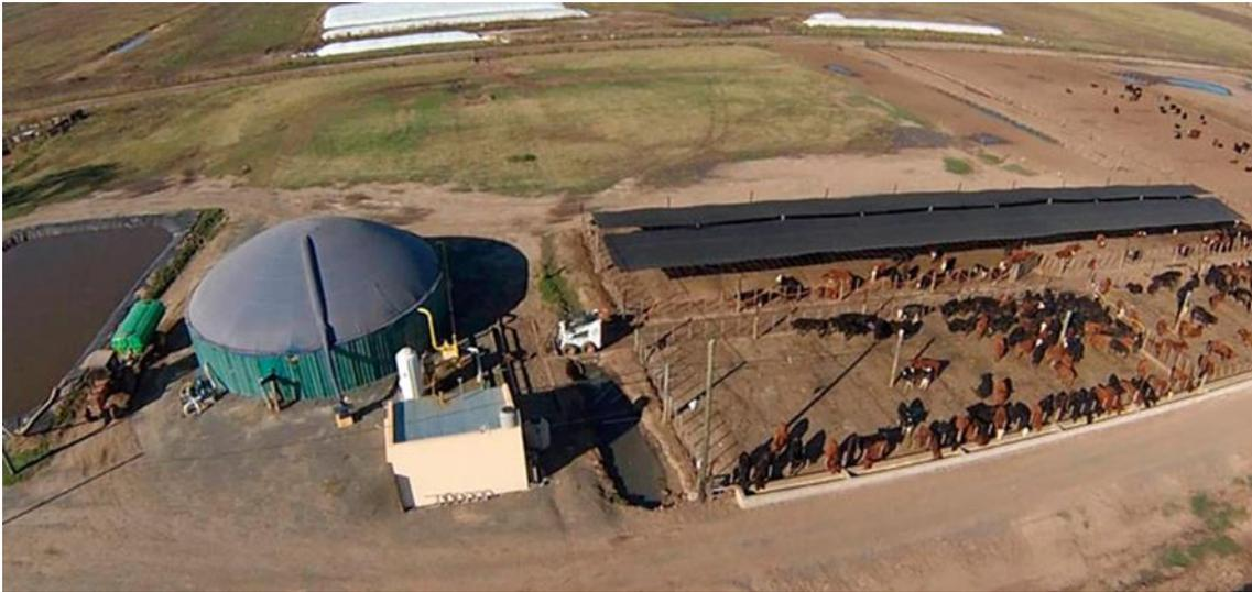
*Figura 2: Feed lot con producción propia de energía de biogás en el biodigestor (domo circular) y su laguna de efluentes (izquierda).*
