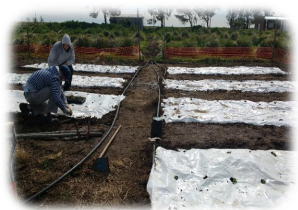
Figura 3. Finalización de armado de las parcelas.
