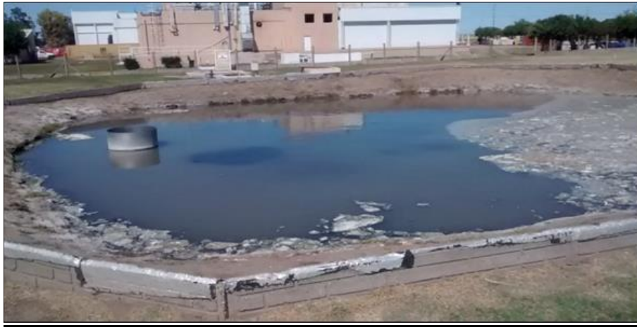
Figura 5: Laguna N° 1 anaeróbica.
