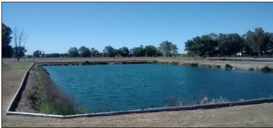
Figura 6. Laguna n°3 aeróbica y receptora
