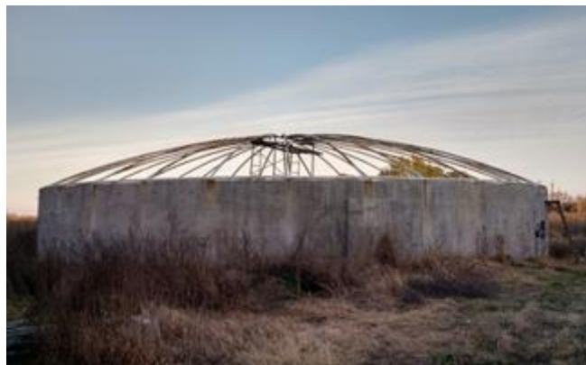
Figura 7. Biodigestor en construcción en la fábrica de quesos La Unión.
