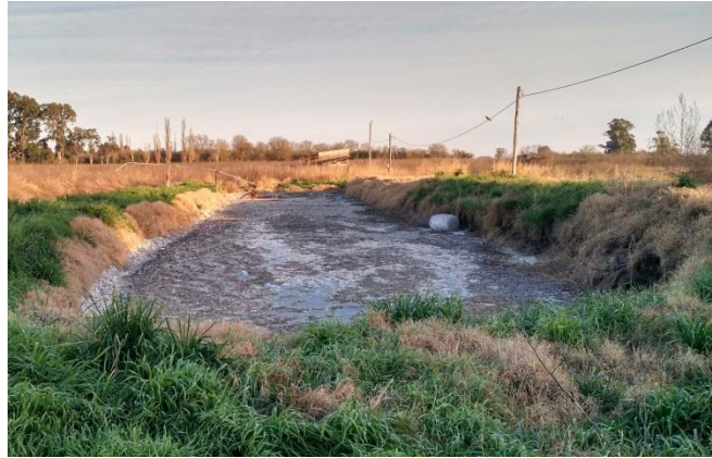
Figura 6. Laguna donde se vuelca el efluente producido en la fábrica
