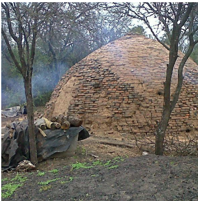
Figura 1.1. Fotografía de un horno pirolítico tradicional del tipo media naranja en la región chaqueña, Argentina.
