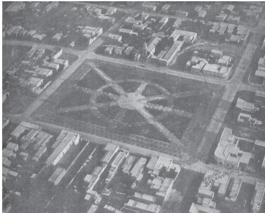
Reparación de la Plaza después de una inundación en 1933. Archivo Estación Rosario.
