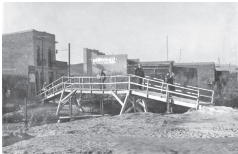
Puente peatonal sobre el Napostá. Ca. 1940. Archivo Estación Rosario.
