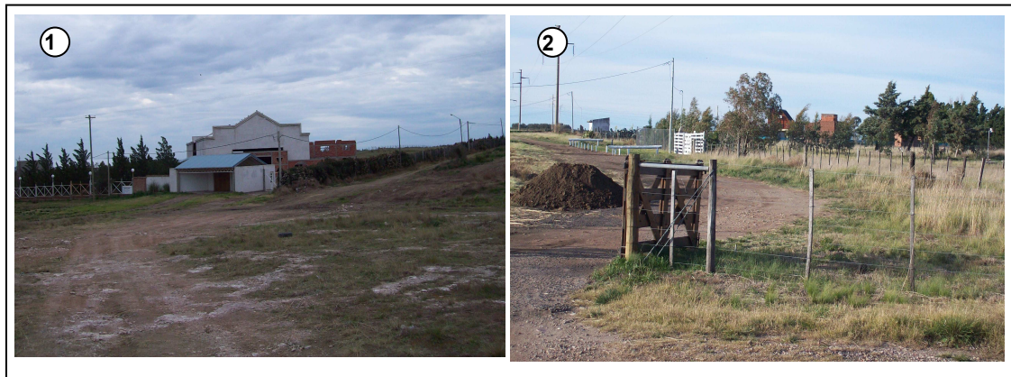
Figura 46 Artefactos de la globalización en el rururbano Norte y Noroeste: nuevas urbanizaciones
