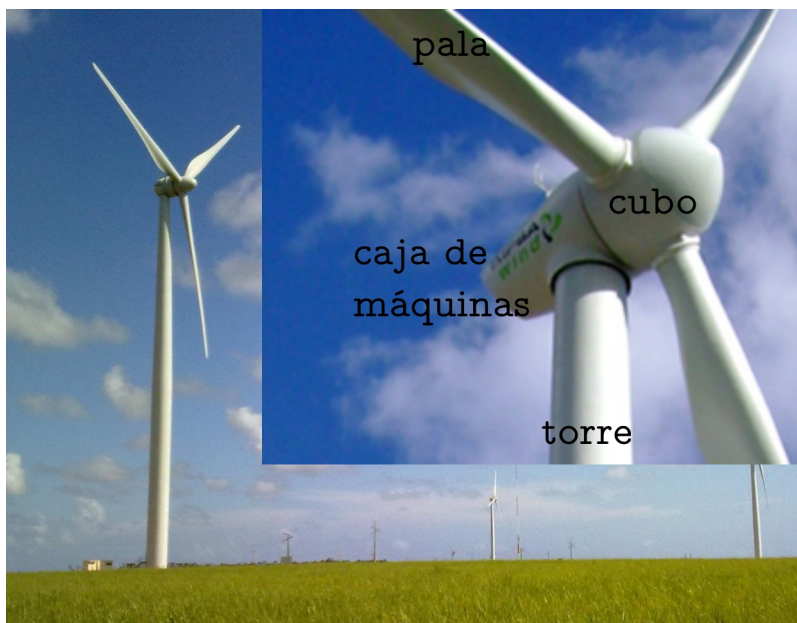
Fig. 1 Vista de un aerogenerador de 1,5 MW. Se pueden apreciar las partes principales de su estructura: torre, palas, cubo y caja de máquinas o góndola (adaptado de [6]).
