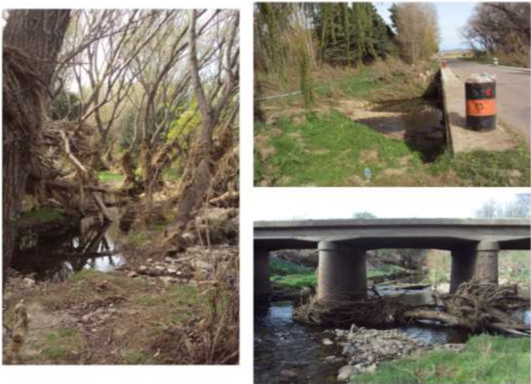
Figura 5.19 Daños ocasionados por la crecida del 17/03/2015.
