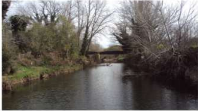
Figura 5.18 Crecida del arroyo San Bernardo en las inmediaciones del puente del ferrocarril.
