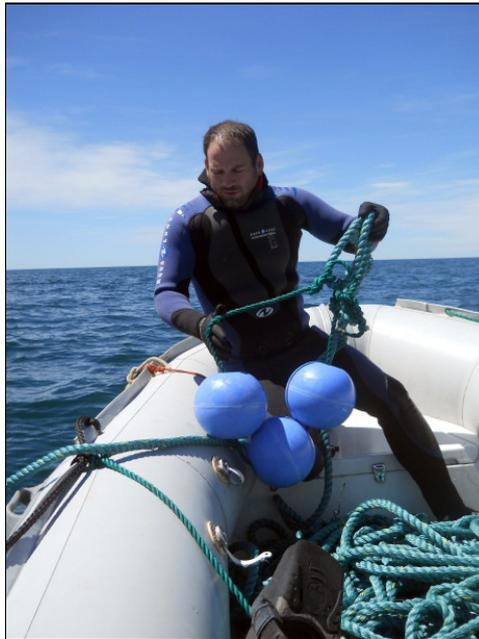
Figura 34: Tarea de colocación del *longline* y su sistema de boyado.
