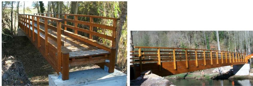
Figura 7.1: Puente peatonal de madera con vigas laminadas.
