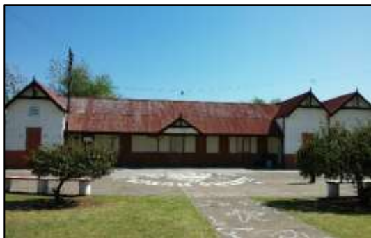
FIGURA 75: Estación Bahía Blanca Noroeste
