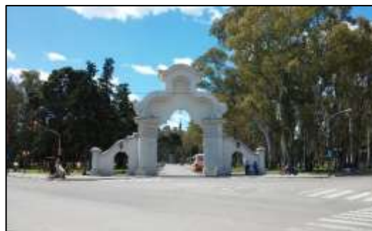
FIGURA 90: Portal de ingreso al parque
