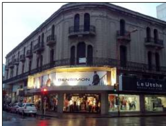
FIGURA 42: Intersección calles Soler y Alsina
