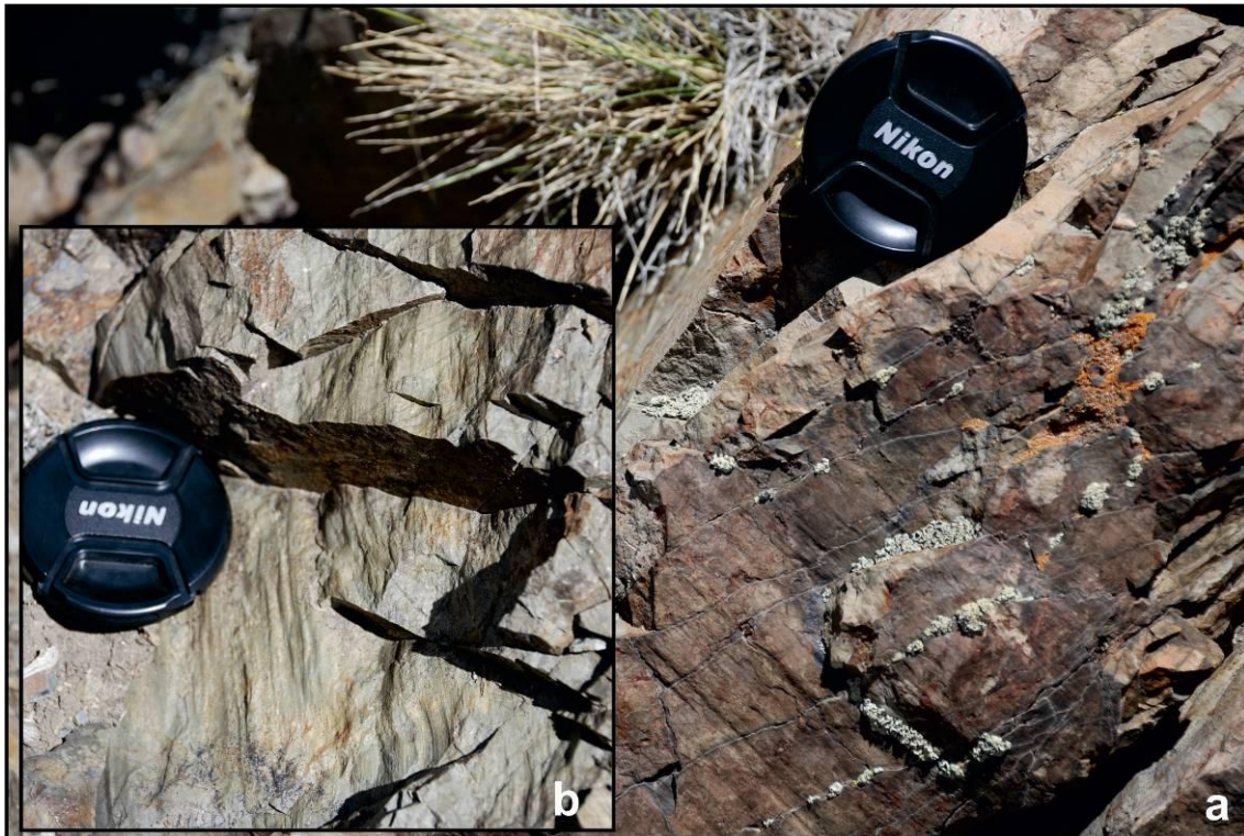
Fig. 3.3.16: a) Estriaciones en el contacto intrusivo- sedimentitas, b) detalle de las mismas.
