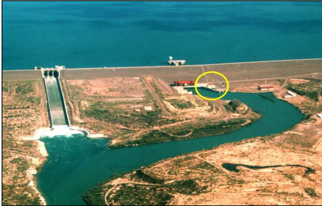
Figura 5.9. Dique Casa de Piedra en 1999. Sobre el paredón, en el círculo, se aprecian la Casa de Máquinas y el sitio donde se ubican las válvulas para riego.
