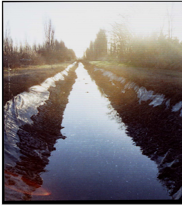
Figura 6.10. Revestimiento de canales con lámina impermeable. Una solución transitoria al problema de las aguas claras en el valle medio del río Colorado.
