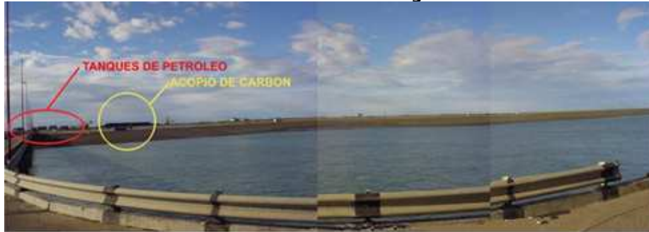
Figura N° 4. Vista de las instalaciones de acopio de petróleo y carbón, ubicadas sobre en el sector inmediato de ingreso al muelle.
