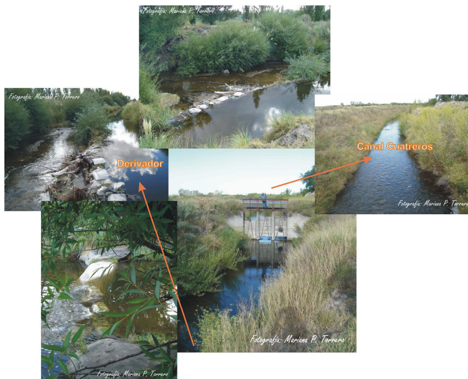
Figura 7.2. Derivador y sistemas de compuertas en el Paraje La Horqueta sobre el río Sauce Chico. Lugar de nacimiento del Canal Cuatrerros.
