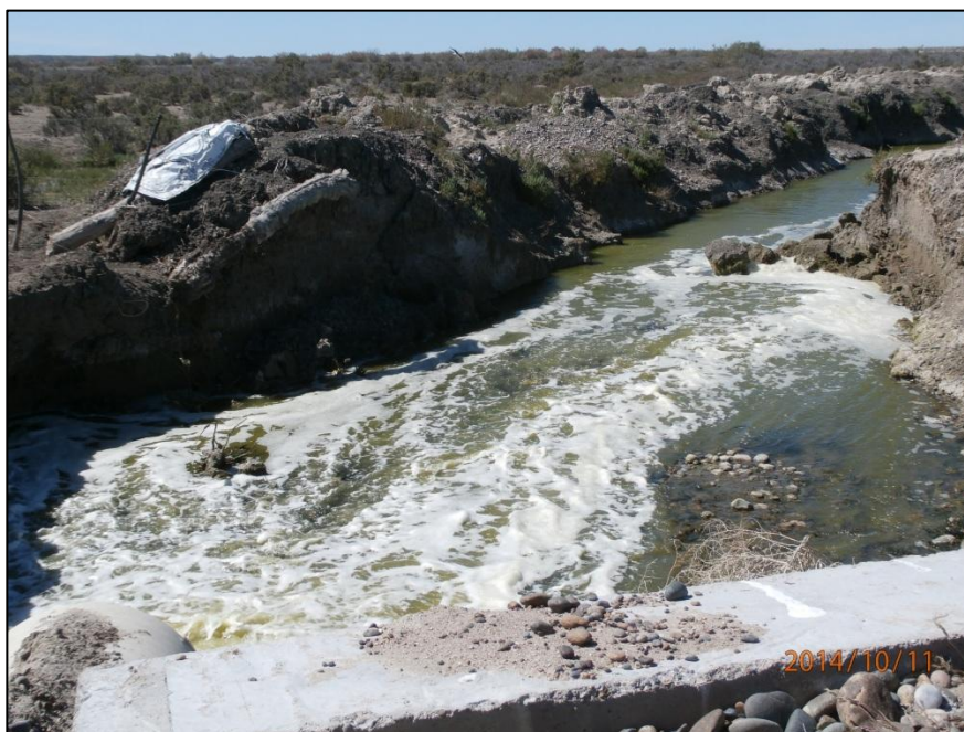
Figura 5.7. Canal que une la laguna IV con la VI o Salitral. Fuente: fotografía de M. Alejandra March. Fecha de registro 11/10/2014.
