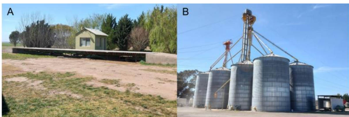
Figura 10. Balanza de camiones (A) y planta de silos (B).
