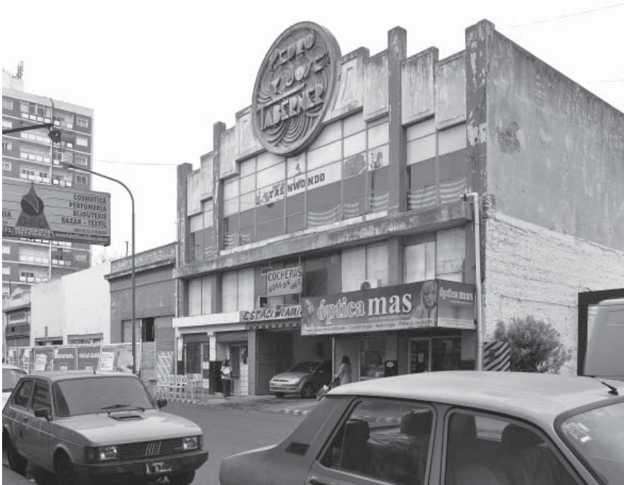
Calle San Martín con vista del edificio Taberner (octubre 2011). Foto de Florencia García Amado.
