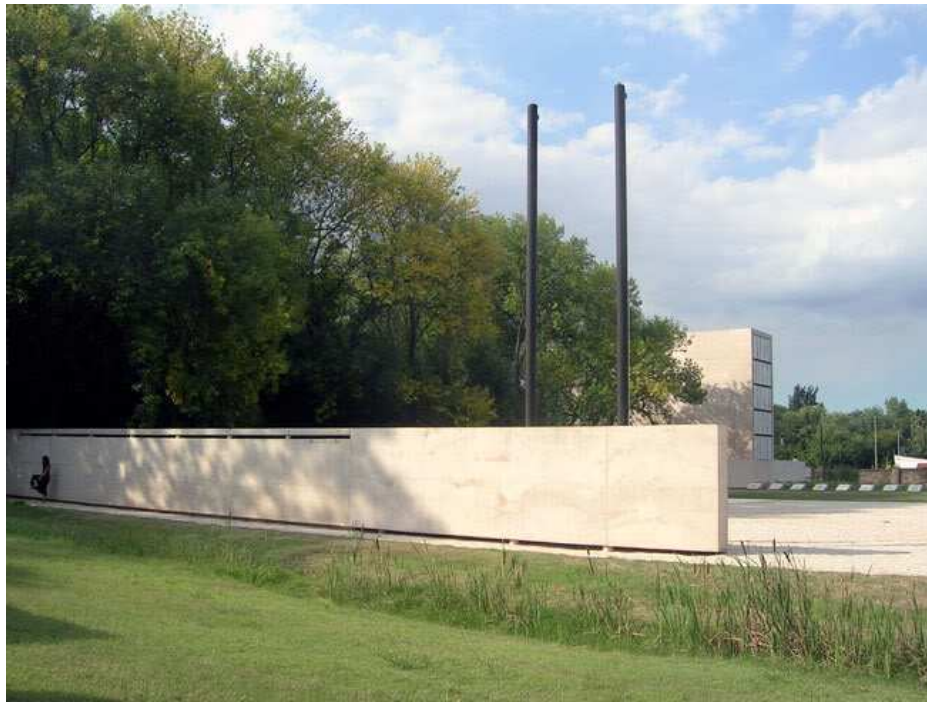
Figura N°15. Mausoleo de Perón, Provincia de Buenos Aires, Hormigonera Valfos, 2006.
