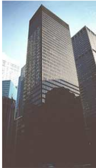
Figura N°3, Arq. Ludwing van del Rohe, Edificio Se agram, 1954-1958, Nueva York
