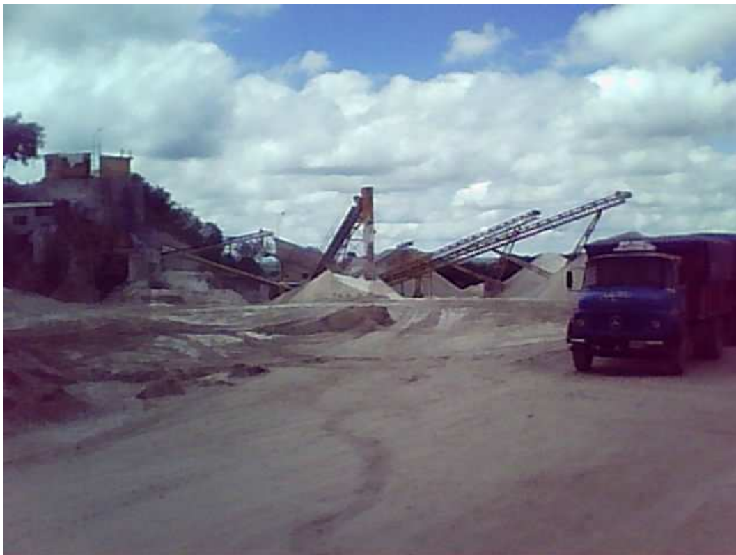
Figura N° 30. Sector de la planta de agregados de cantera San Agustín
