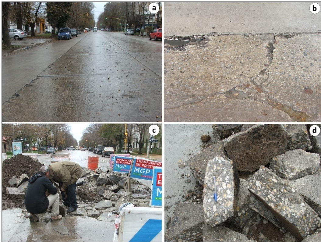
Figura 8.31: Avenida Libertad: (a) Vista del pavimento. (b) Detalle: fisuras mayores a 1 cm y erosión en bordes (bache) en tramo de la avenida en servicio. (c) Fragmentos de losa del tramo levantado. (d) Detalle de las losas donde se aprecian los agregados cuarcíticos.
