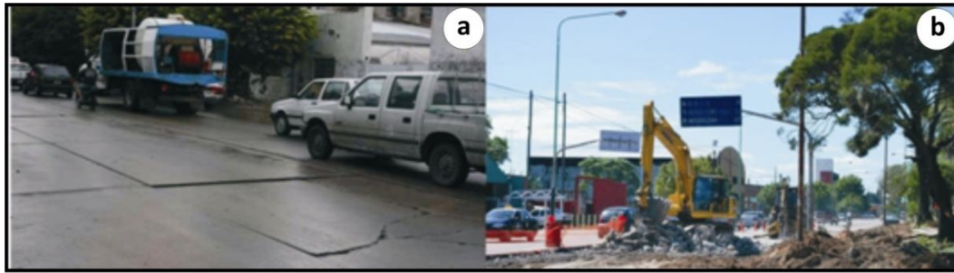
Figura 8.20: (a) Pavimento afectado por fisuras longitudinales y transversales, hundimiento de losa y escalonamiento de juntas. (b) Trabajos de remoción de las losas de hormigón.
