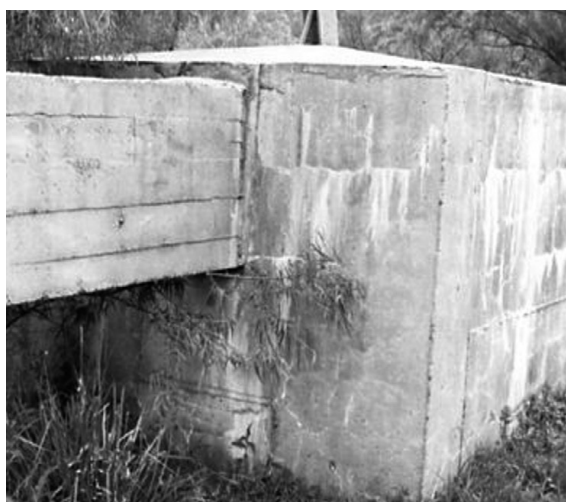
Figura 1.1: Base torre de alta tensión de Salto Grande, Entre Ríos. Se observa un patrón de fisuras tipo “mapa” y chorreaduras blanquecinas de materiales de RAS (tomado de Falcone y Batic†2012).
