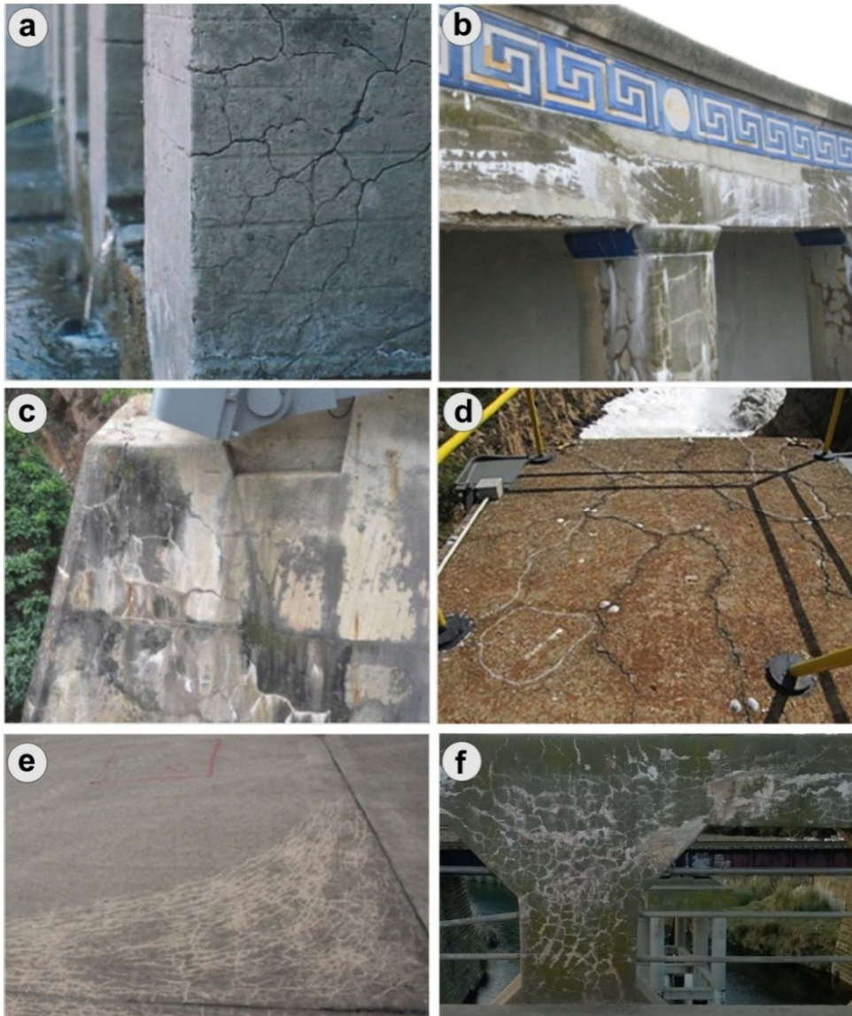
Figura 4.15: Estructuras afectadas por la RAS. (a) fisuración a 120^\circ en pilar de compuerta, presa Cinco Saltos, Río Negro (Falcone 2013); (b) casa de playa en Nueva York (1930), con fisuras paralelas a las armaduras y productos de la RAS (Bentivegna y Ideker 2016); (c) presa de Pirapora (Brasil), contrafuerte con fisuración y eflorescencias; (d) fisuración con patrón a 120^\circ en la parte superior del contrafuerte (Pirapora); (c) y (d) tomadas de Sollero et al. (2016); (e) pavimento de un aeropuerto en Japón con patrón de fisuras de la RAS, Kawamura et al. (2016); (f) fisuras típicas de RAS con relleno y chorreaduras de material blanquecino sobre la cara interna de un puente vial de 1925, Sierra de la Ventana, Prov. de Bs. As. (Imagen de autor).
