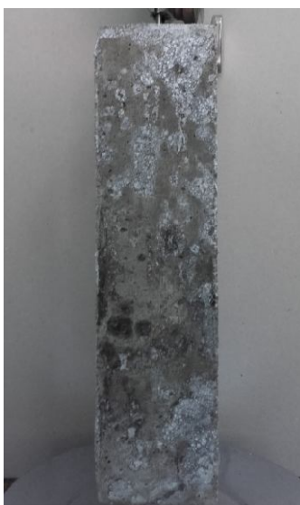
Figura 5.4: Prisma de hormigón post-ensayo con eflorescencias sobre la superficie.
