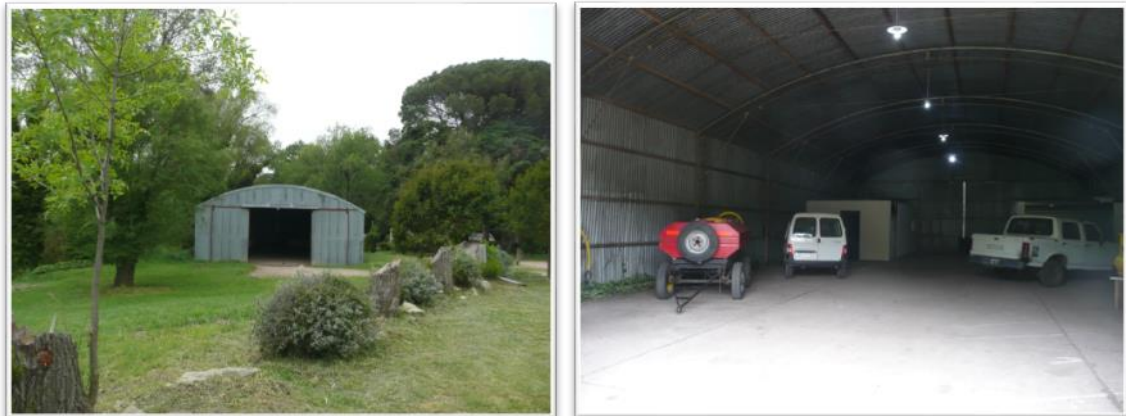
Figura 1.15. Instalaciones y equipamiento para combatir incendios (PPET)
