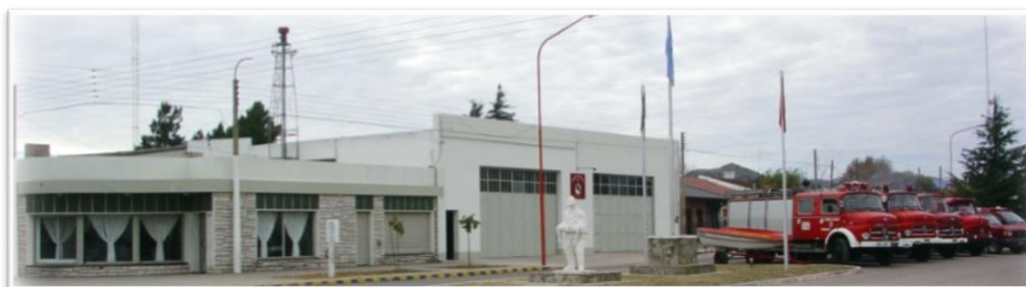
Figura 4.7. Instalaciones del cuartel de Bomberos Voluntarios de Tornquist
