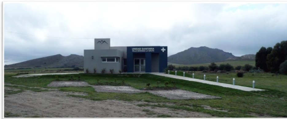
Figura 4.14. Unidad sanitaria de VSLG
