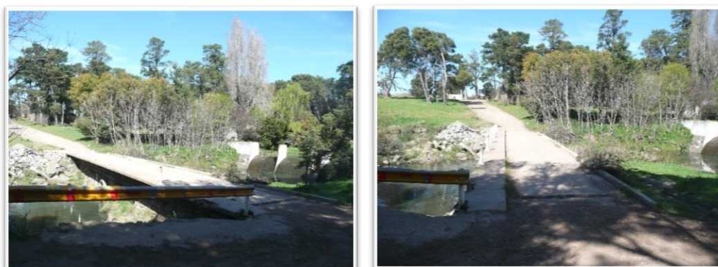
Figura 4.13. Puente sobre el Arroyo El Belisario, Villa Ventana
