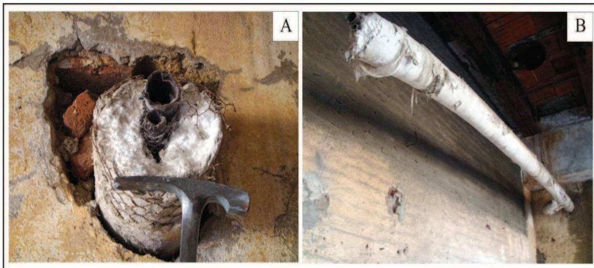
Figura 12.27: A. Caño truncado recubierto de material fibroso. B. Caños que atraviesan paredes del primer piso del edificio.
