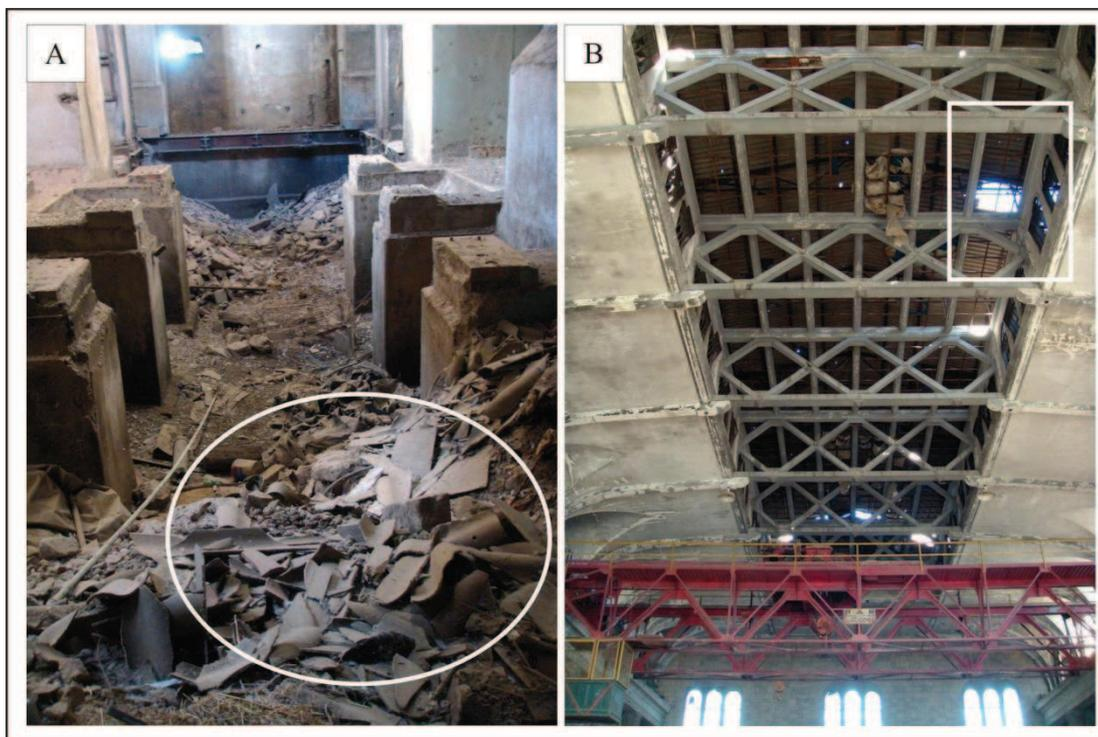
Figura 12.4: A: Planta baja. Escombros y fragmentos en el suelo de losas. B. Material desprendido del techo y vitreaux.
