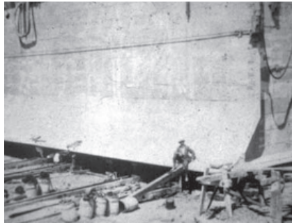
Construcción y remolque de los cajones para construir el Puerto de Arroyo Pareja c.1914 (Archivo Histórico Municipal de Punta Alta).
