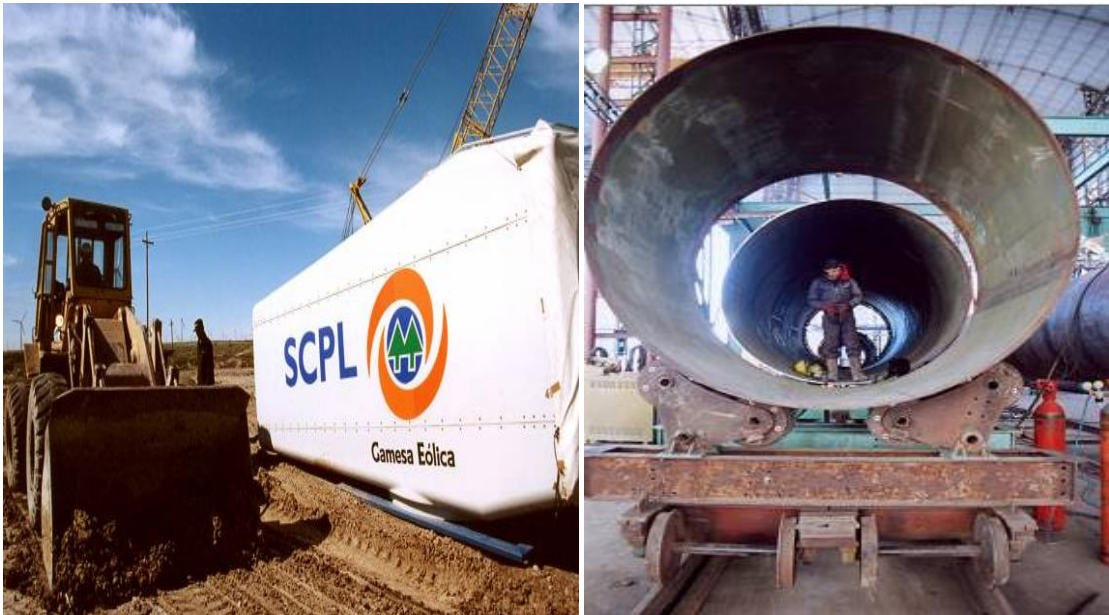
Figura N° 29. Góndolas y partes de las torres de los últimos equipos incorporados al Parque eólico Antonio Morán, provincia de Chubut.
