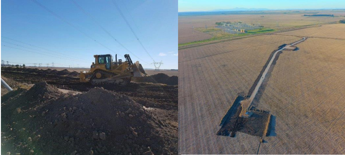
Figura N° 90. Construcción de 20 km de caminos desde la Ruta Provincial N°51. Fuente: http://www.lanueva.com/la-ciudad/901394/comenzaron-las-obras-en-el-parque-eolico-corti .
