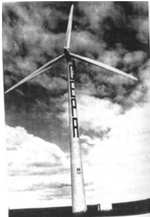
Figura N° 68. Primer aerogenerador instalado en la provincia de Buenos Aires. Pehuen-Có, Año 1995.
