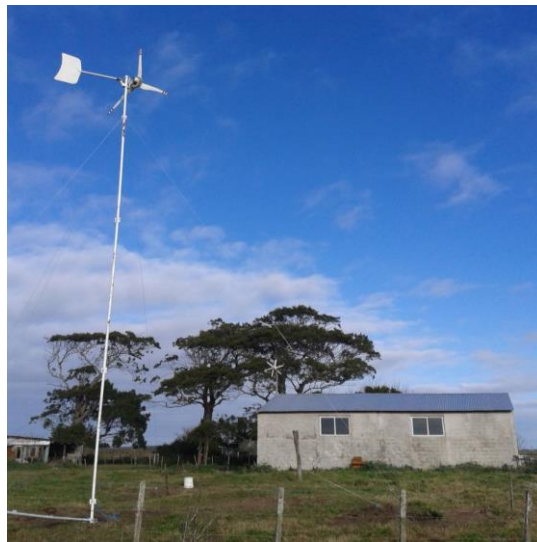
Aerogenerador de baja potencia en un establecimiento rural de General Lavalle, Buenos Aires. Fuente: Eolocal, 2015
