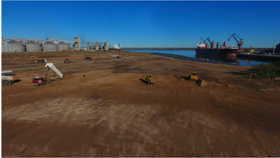
Figura N° 94. Obras en la zona de Puerto Galván para el futuro almacenaje de los aerogeneradores importados.
