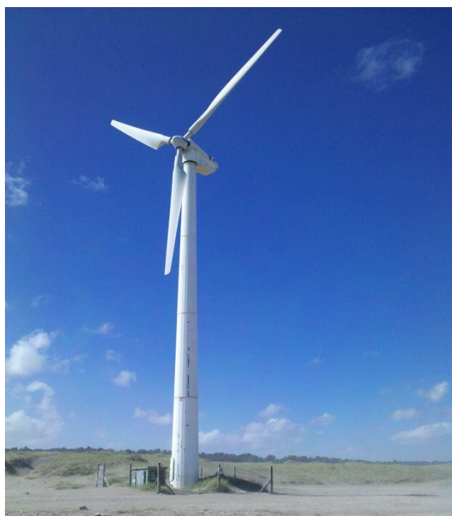
Figura N° 83. Parque eólico ECOS, Necochea. Fuente: informante calificado, 2014.
