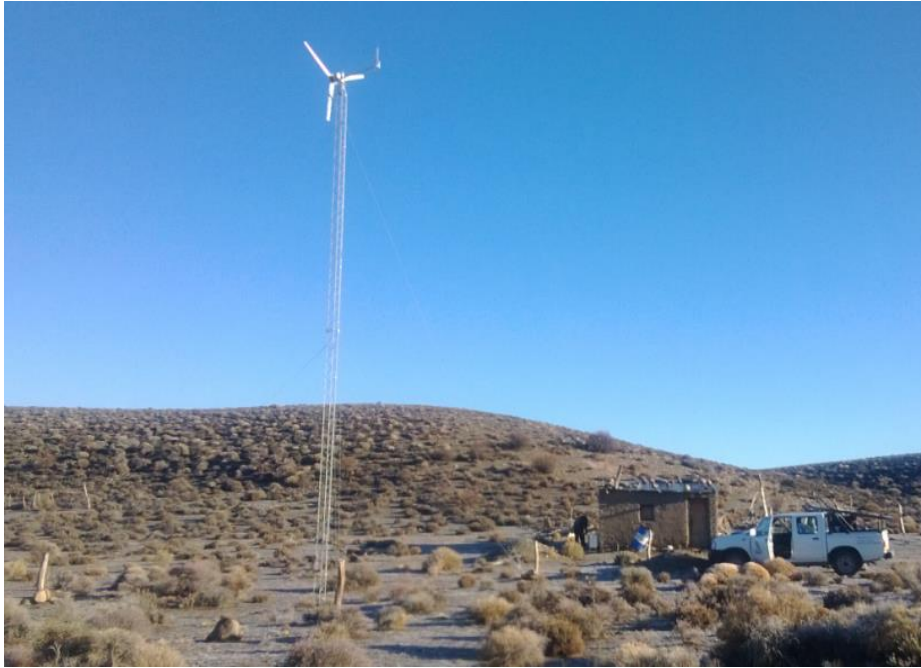
Figura N° 17. Aerogenerador de baja potencia en vivienda rural, provincia de Chubut. Fuente: Schaube, 2015.
