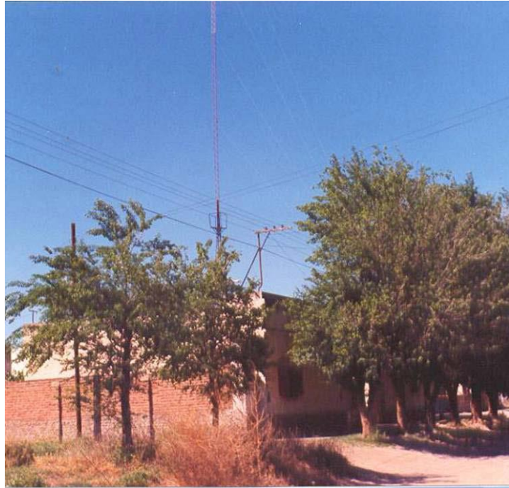
Figura N° 72. Torre de medición de vientos instalada en Mayor Buratovich. Año 1993. Fuente: Cronología de Eventos Relacionados al Parque Eólico, CESMAB.
