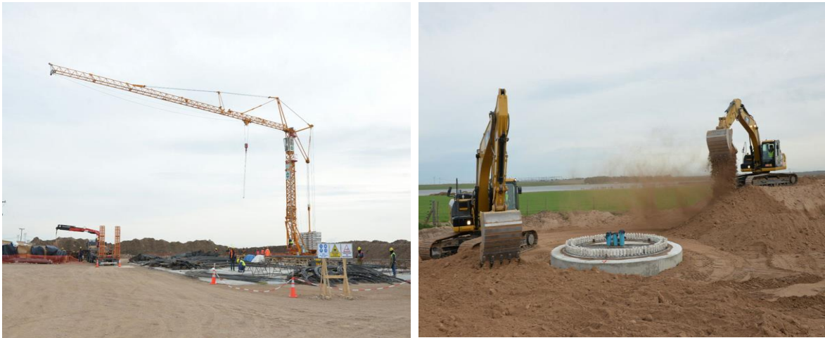
Figura N° 91. Ejecución de fundaciones hormigonadas como base de los aerogeneradores.
