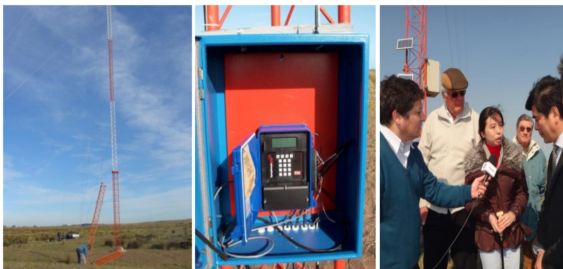
Figura N° 85. Instalación e inauguración de la torre de medición de vientos en Reta. Año 2013
