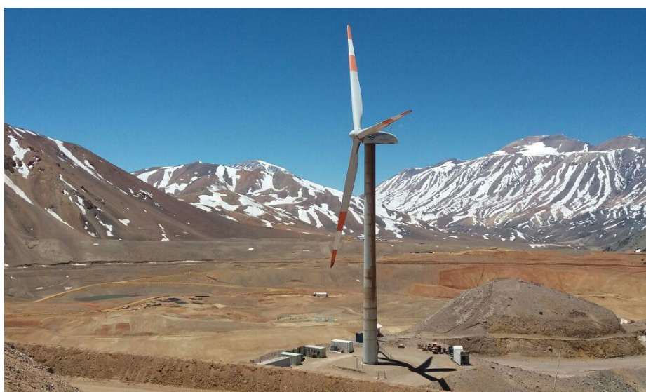
Figura N° 30. Aerogenerador de alta potencia en mina Veladero, provincia de San Juan. Fuente: Carrizo, 2016.
