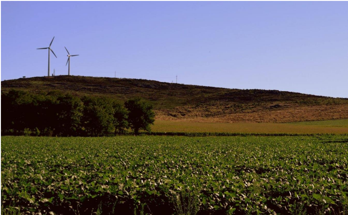
Figura N° 78. Parque eólico CRETAL, partido de Tandil. Fuente: Tomada en febrero de 2014.
