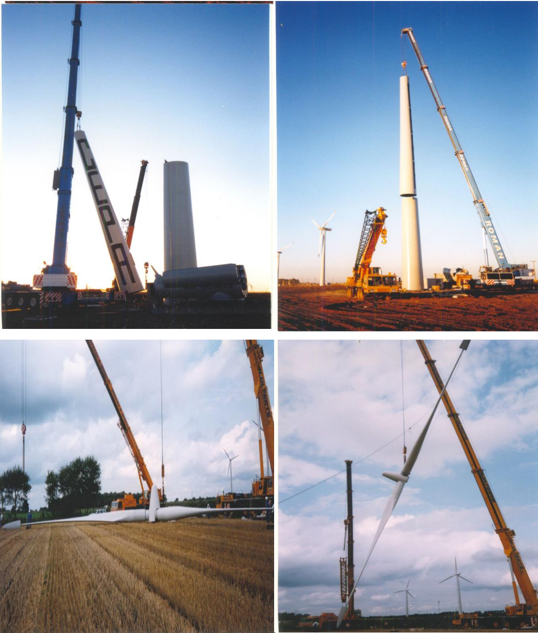
Figura N° 69. Montaje de los aerogeneradores del parque eólico Centenario. Año 1995. Fuente: Archivo Histórico Municipal de Punta Alta.
