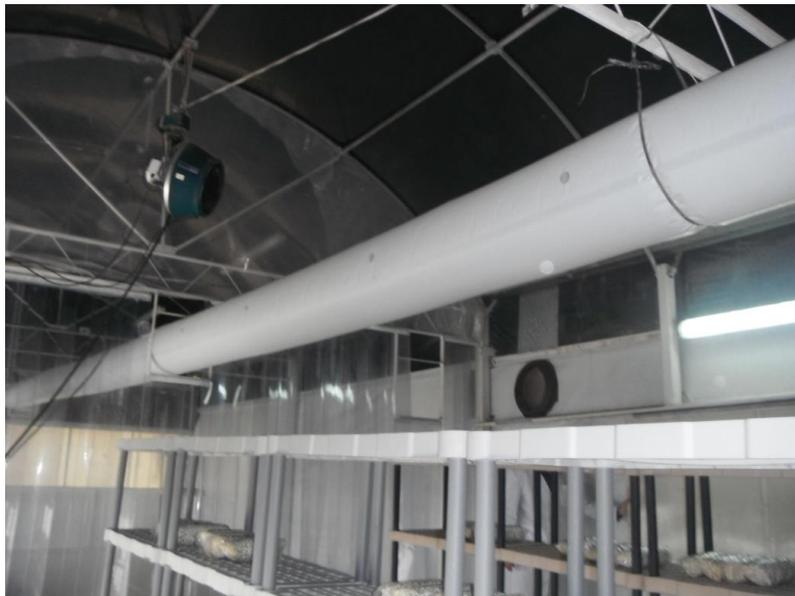
Figura 9: Sistema de distribución de aire filtrado.
