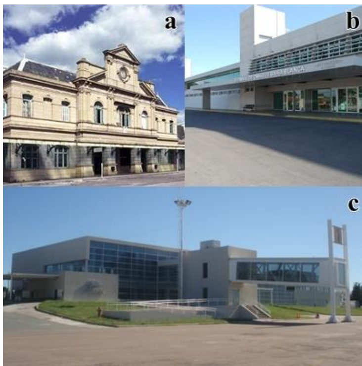
Figura 6 Estación Sud, Terminal de Ómnibus San Francisco de Asís y Aeropuerto Comandante Espora de Bahía Blanca
