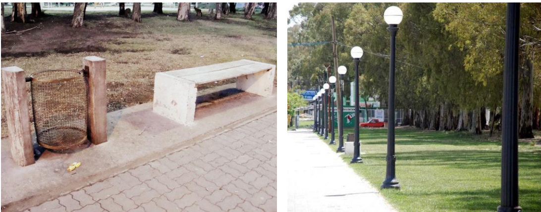
Figuras 31 y 32 Estado de los caminos, luminarias y bancos
