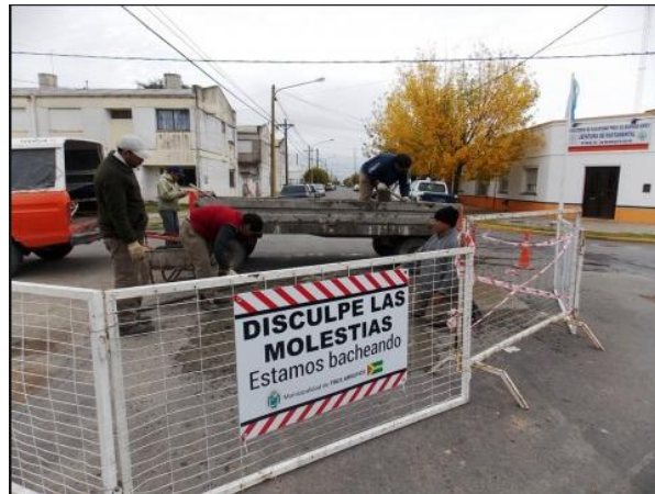
Figura 21 Obras de Bacheo
