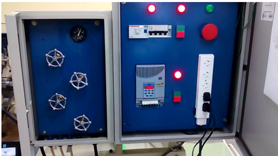
Figura 6.65: Tablero del banco en funcionamiento. Se aprecia el manómetro indicando la presión de suministro (en 65 Psi) y la frecuencia de giro del motor (en 50Hz).
