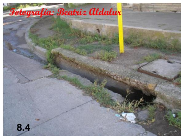
**Fotografía 8.3. y Fotografía 8.4. Sumideros: metálico y de hormigón.**
