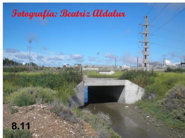
**Fotografía 8.10. y Fotografía 8.11. Cabecera del canal Profertil y alcantarilla sobre ruta.**
