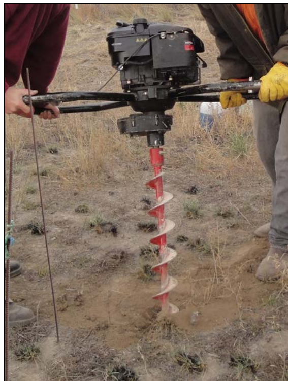
Figura 8.1. Fotografía de la perforadora a motor empleada para enterrar los cilindros.
