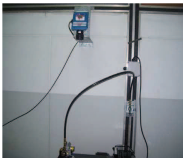
Figura 5.9. Montaje del sensor de presencia de hidrógeno.
