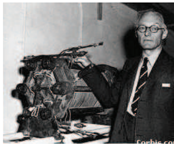
Figura 1.10. Francis T. Bacon con su batería de 40 celdas.
