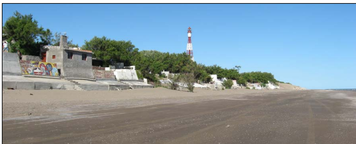
Figura 6.4. Vista parcial del sector “C”.
