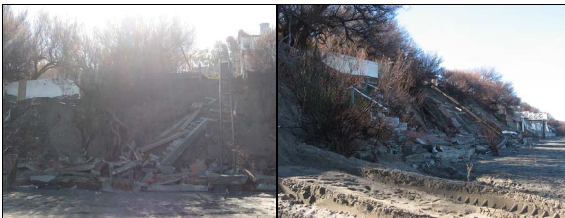
Figura 6.38. Vistas de la destrucción provocada por la tormenta de julio de 2009 en viviendas del sector C.
