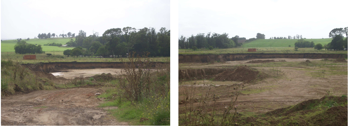
Foto 32 y 33. Extracción de suelos sobre calle sin nombre, entre Ruta 88 y Av. Tetamanti.
