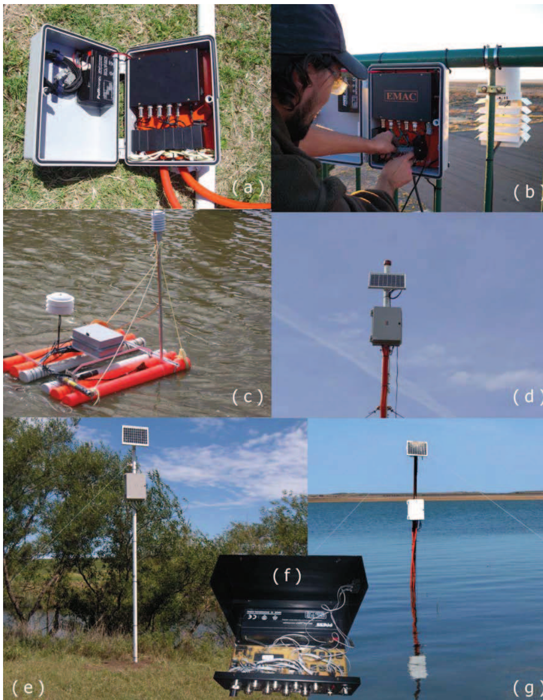
Figura 3.1: Vista de EMAC y su datalogger en diferentes locaciones. (a) Villa del Mar pre - instalación. (b) Las Grutas. (c) Laguna Sauce Grande. (d) Villa del Mar pos - instalación. (e) Necochea, Río Quequen. (f) Vista interna del datalogger. (g) San Blas.
